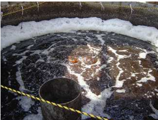
良い状態の時の曝気槽 発泡が少なく、泡がはじけます。
